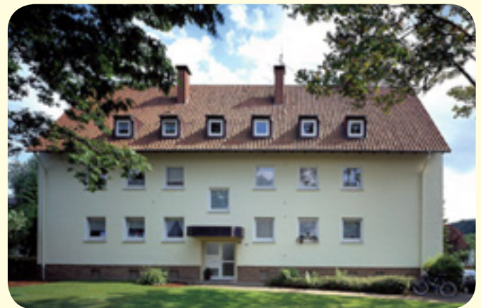
Moorlandstraße 48: vor der Modernisierung...
