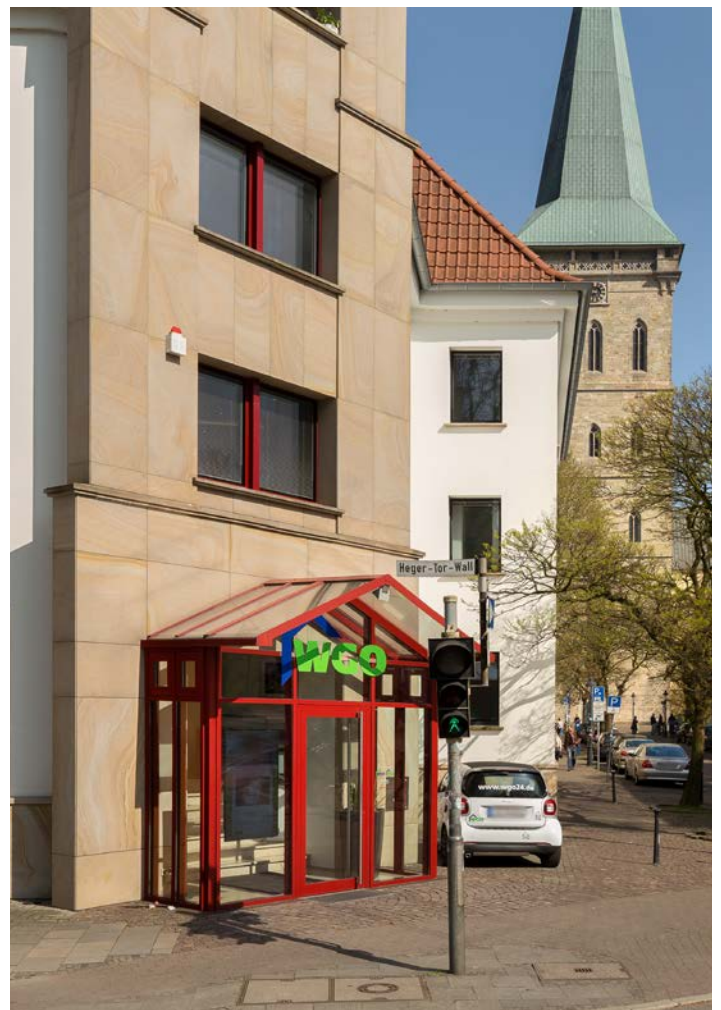
Verwaltungsgebäude in Osnabrück, Katharinenstraße 10
