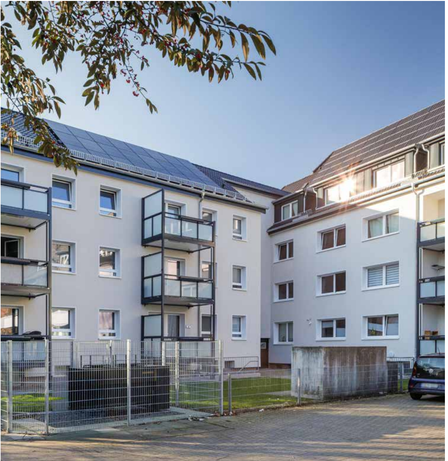
Rückansicht Wesereschstraße/Kreuzstraße, Osnabrück
